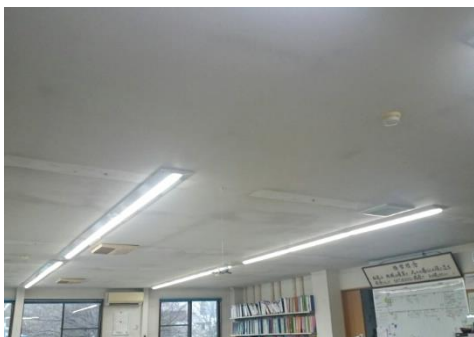
LED照明向き変更
