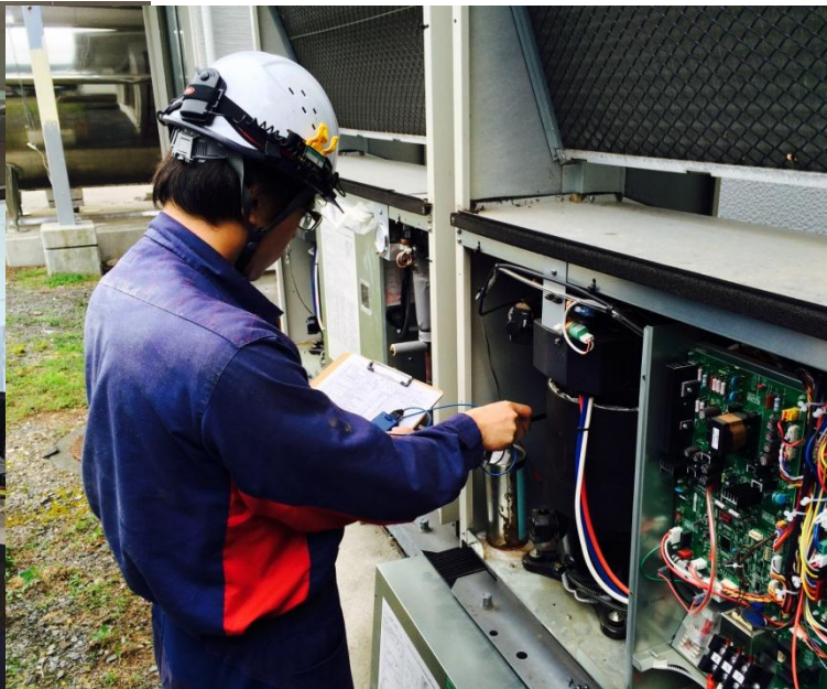
<点検作業イメージ>
