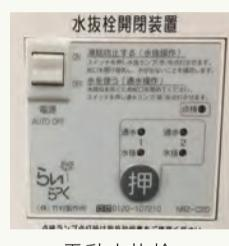
室内から開閉できるようにするための遠隔開閉器というものがおすすめです。また、リモコンのボタンで開閉できる電動水抜栓もあります。気になる方はぜひご相談ください。
