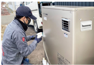
給湯ボイラー交換の様子
