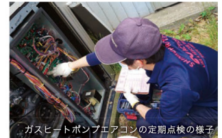
ガスヒートポンプエアコンの定期点検の様子
