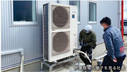
作業現場の様子を見る社長
